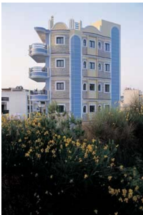
Εικόνα 3.4 Σύγχρονη αρχιτεκτονική στην Ν.Ιωνία, Καλογρέζα
