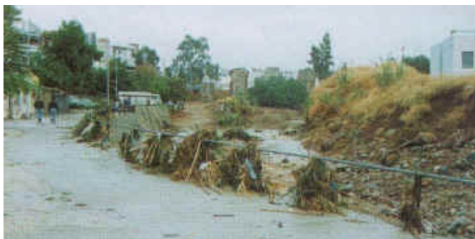
Εικόνα 1.7 Πλημμύρες στον Ποδονίφτη τον Οκτώβριο του 1994
