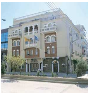
Εικόνα 1.1 Το κτίριο της μητρόπολης Νέας Ιωνίας και Φιλαδέλφειας
