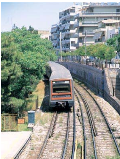
Εικόνα 4.1 Ο ηλεκτρικός σταθμός στα Πευκάκια
